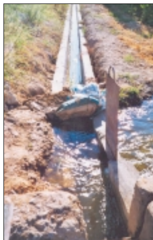
Fotografía N° 40. Toma de parcela 1.569 en A.48.
