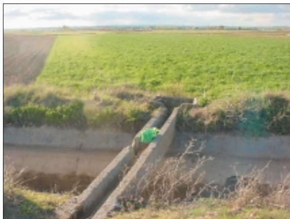
Fotografía N° 8. Murete sobre Canal Villaralbo.
