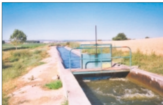
Fotografía N° 24. Tramo inicial del Canal de Madridanos.
