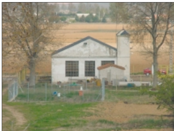
Fotografía N° 6. Estación elevadora del Canal Madridanos-Moraleja.
