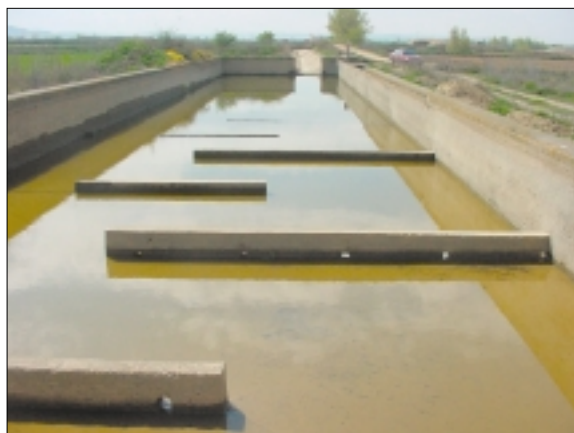
Fotografía N° 10. Laberinto de decantación.
