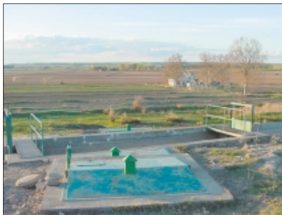
Fotografía N° 7. Partidor en Canal Madridanos-Moraleja y estación elevadora.
