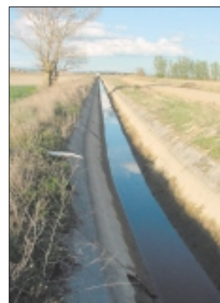
Fotografía N° 1. Canal de Villalarbo.
