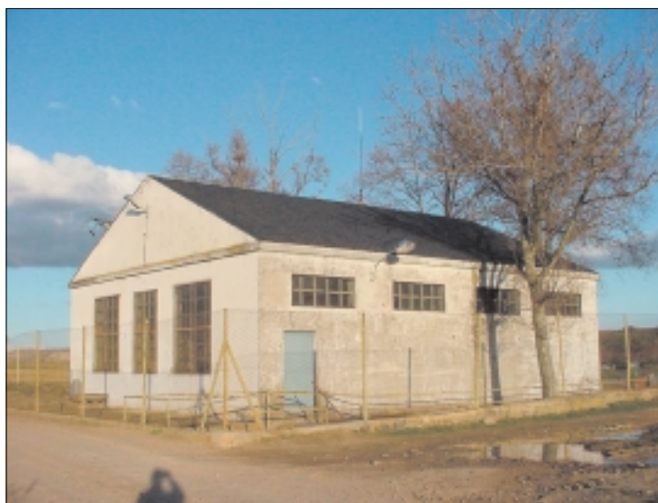
Fotografía N° 5. Estación elevadora del Canal Madridanos-Moraleja.
